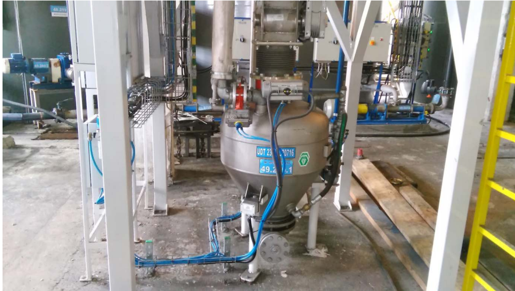
Rys. 3. Podajnik komorowy suchego flokulanta
