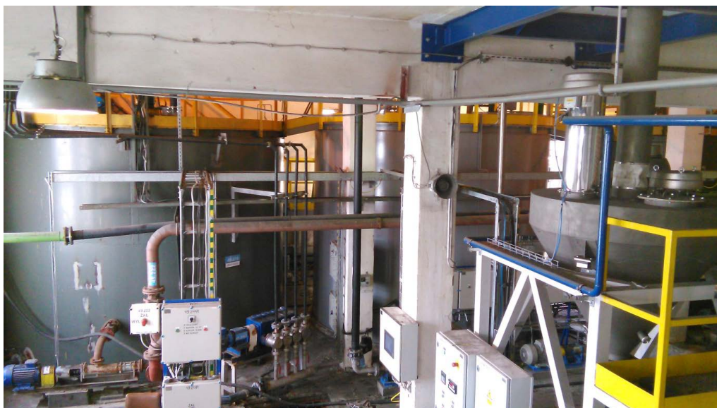
Rys. 6. Zbiorniki ciekłego flokulanta i zbiornik buforowy suchego flokulanta
